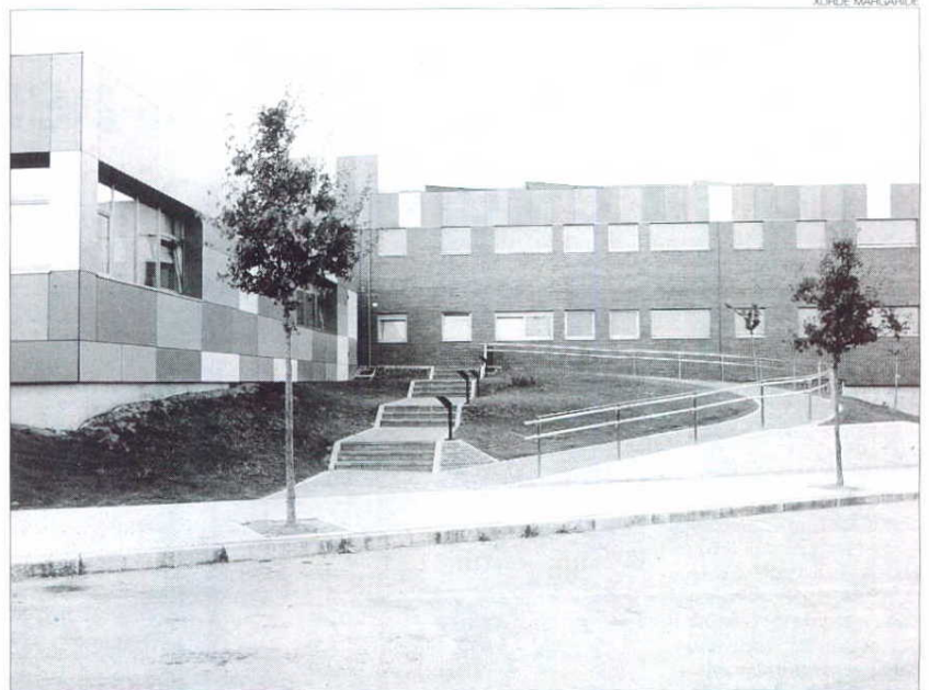
►► Centro de atención integral a las mujeres víctimas de violencia de género en Gijón (Casa Malva).
